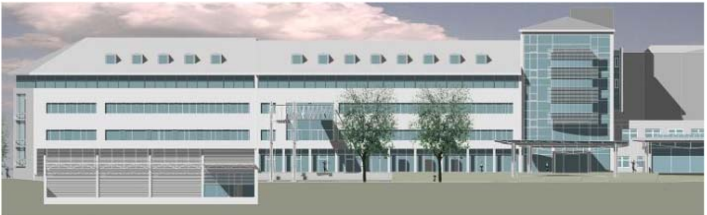
Eingangsbereich und Funktionstrakt Marienhospital Osnabrück (ab 2006)
